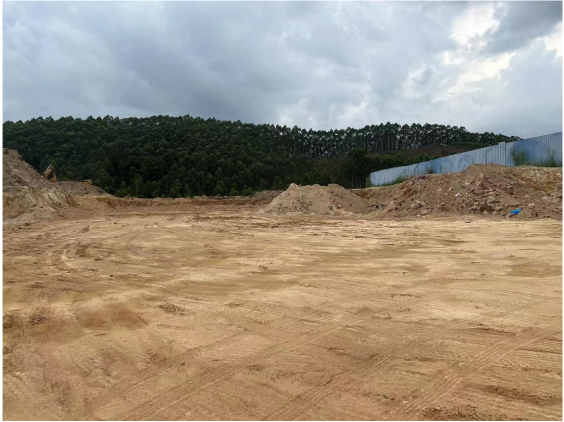
照片 1 地块现状
