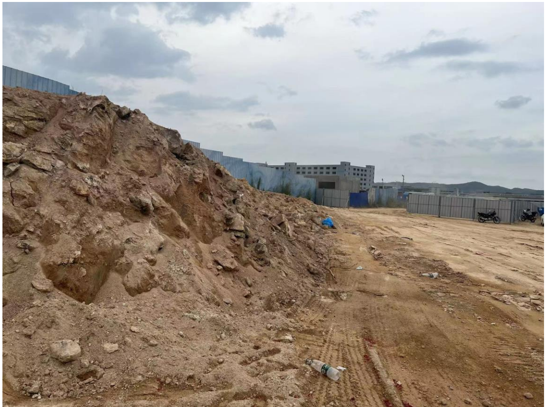
照片4 地块现状
