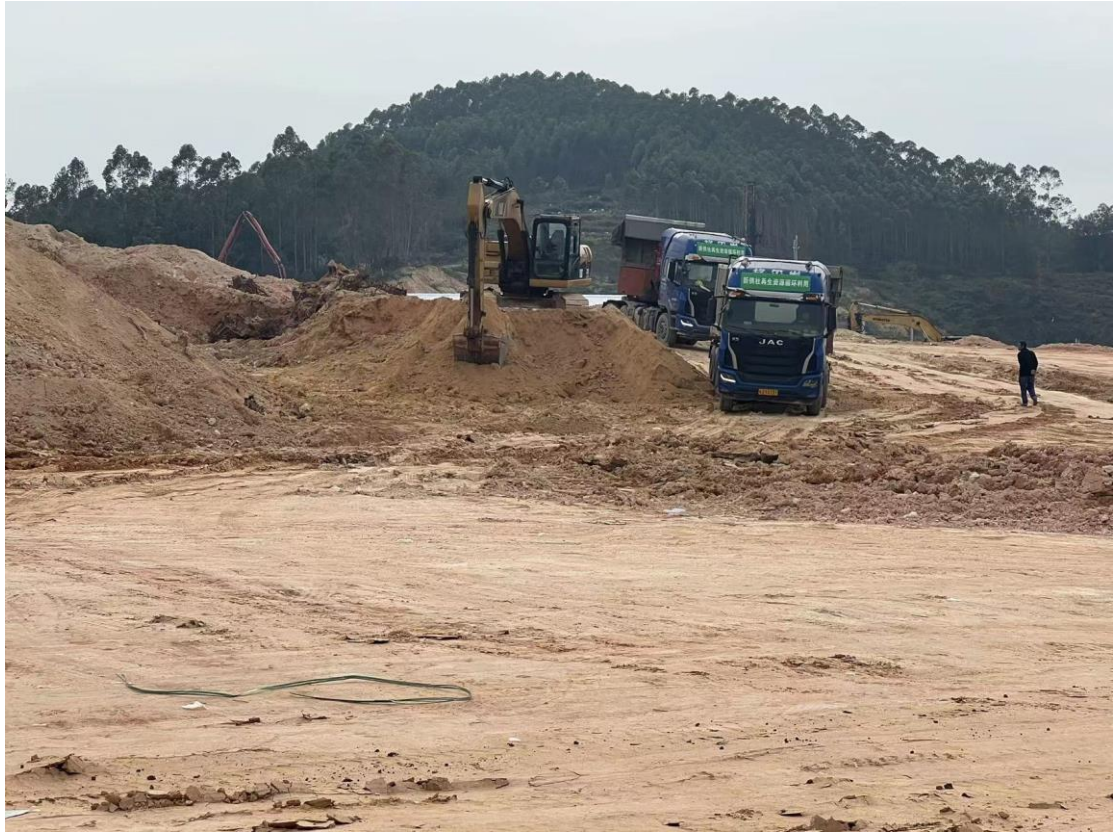
照片 3 地块现状
